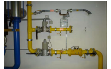
1 Freiverlegte Erdgasleitungsanlage
